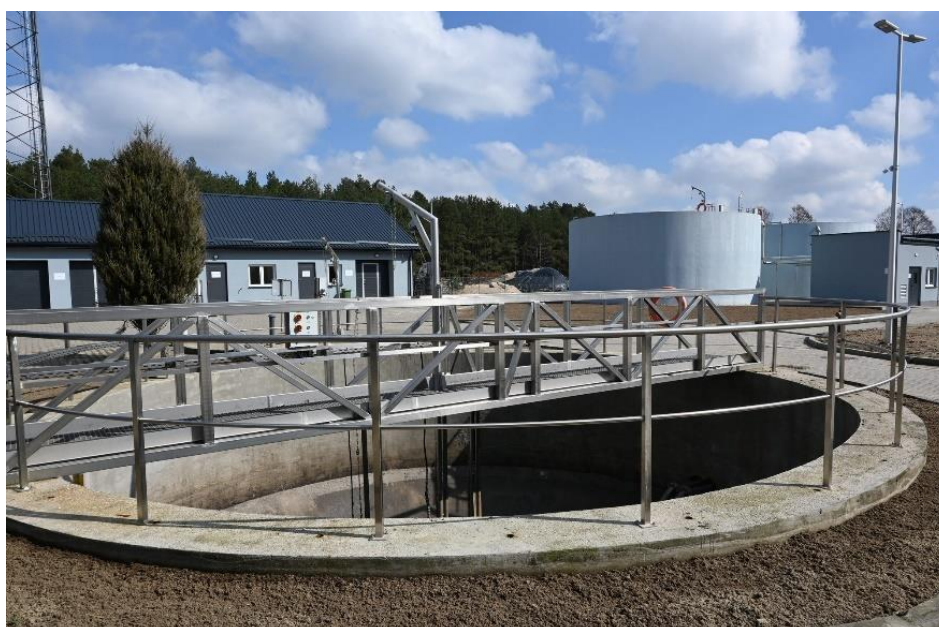
Fot. 9 Oczyszczalnia ścieków w Skrwilnie.
