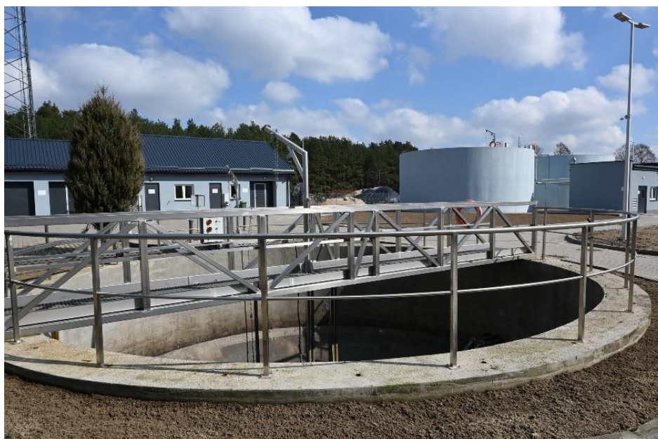
Fot. 9 Oczyszczalnia ścieków w Skrwilnie.
